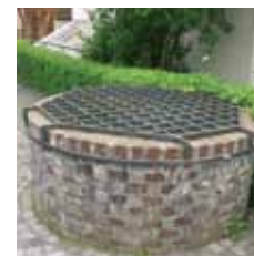
Tiefbrunnen am Pfarrzentrum
