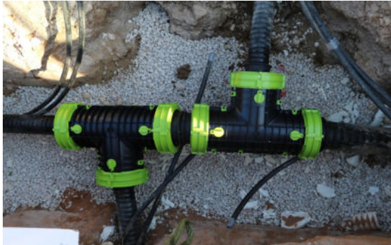
T-Stück im offenen Graben
