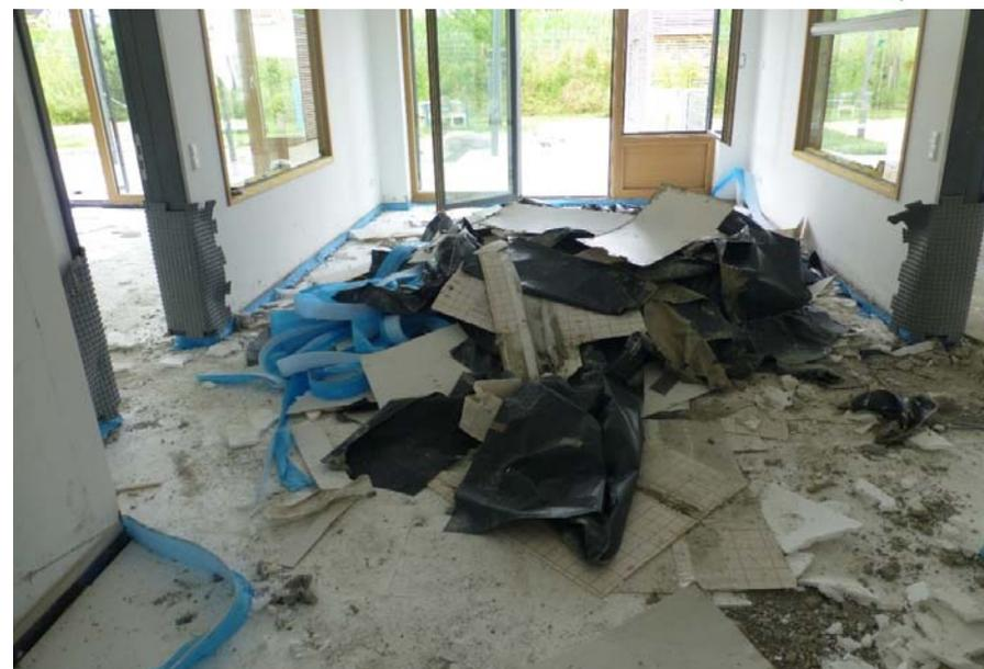
Anschließend wurde der komplette Fußbodenaufbau herausgebrochen und entfernt.
