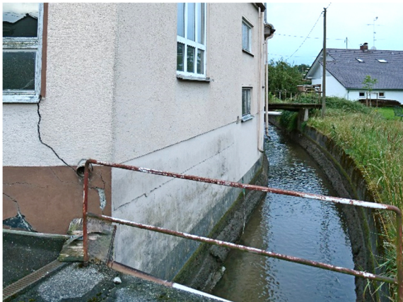
Foto 5: Kanalisierter Lauf der Friedberger Ach unmittelbar westlich von Gebäude Nr. 3
