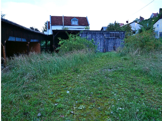
Foto 3: Geräteschuppen (Nr. 2a, Mitte) und ehemaliger Lagerschuppen (Nr. 2b, links) mit ruderalisierten Grünflächen bzw. Kraut-/Staudenfluren
