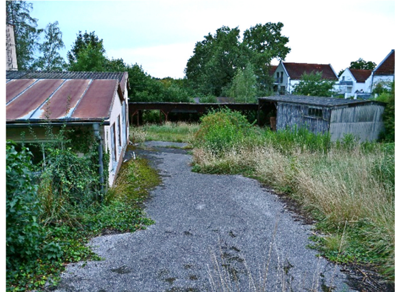
Foto 4: Zufahrt von Osten (Achstraße) im Norden des Geländes mit Gebäuden Nr. 2a (rechts), 2b (Mitte) und 3 (links)
